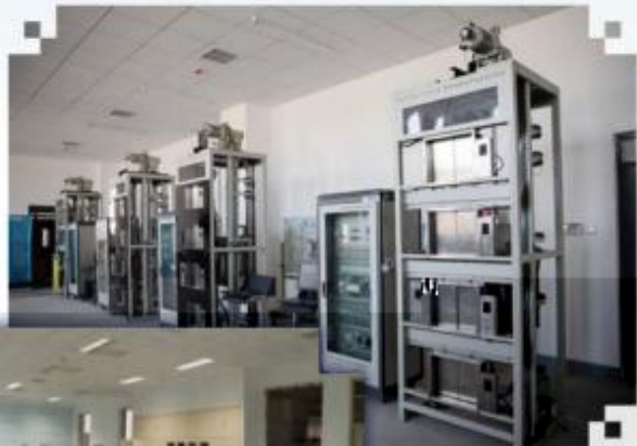
智能电梯安装调试 维护训练场所
